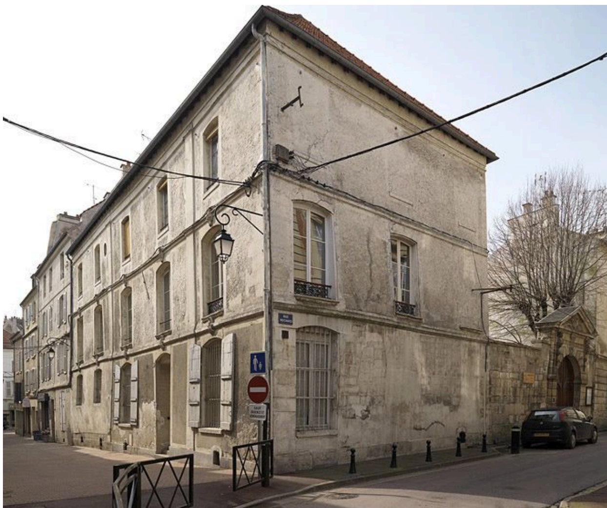
Vue d'ensemble, depuis l'angle de la rue Rochard et de la rue Tronchon.
