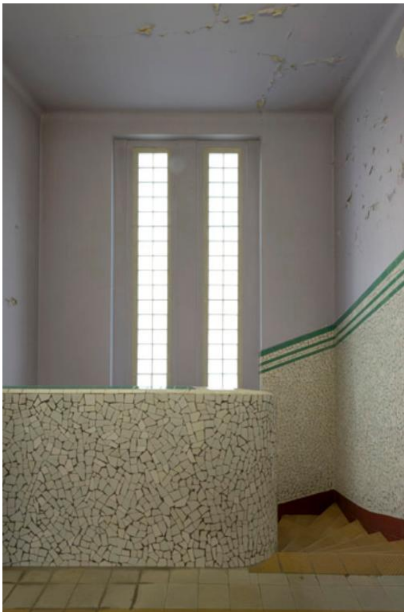
Le palier du premier étage.
