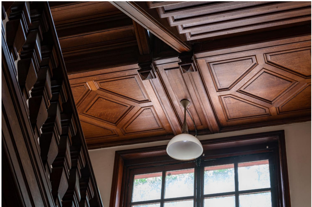
Caissons du plafond de l'escalier
