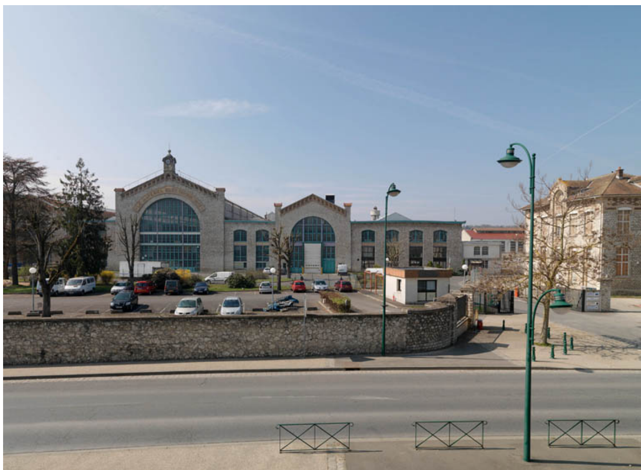
Vue extérieure de l'usine depuis la voie ferrée. La nef centrale et la liaison longitudinale nord.
