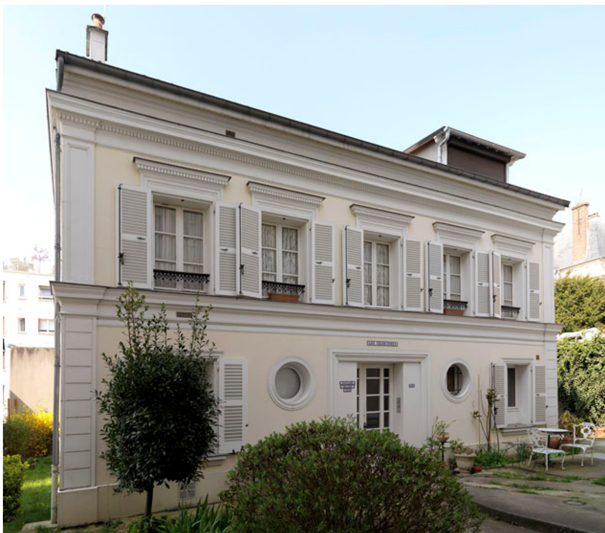
Vue d'ensemble de la façade antérieure.
