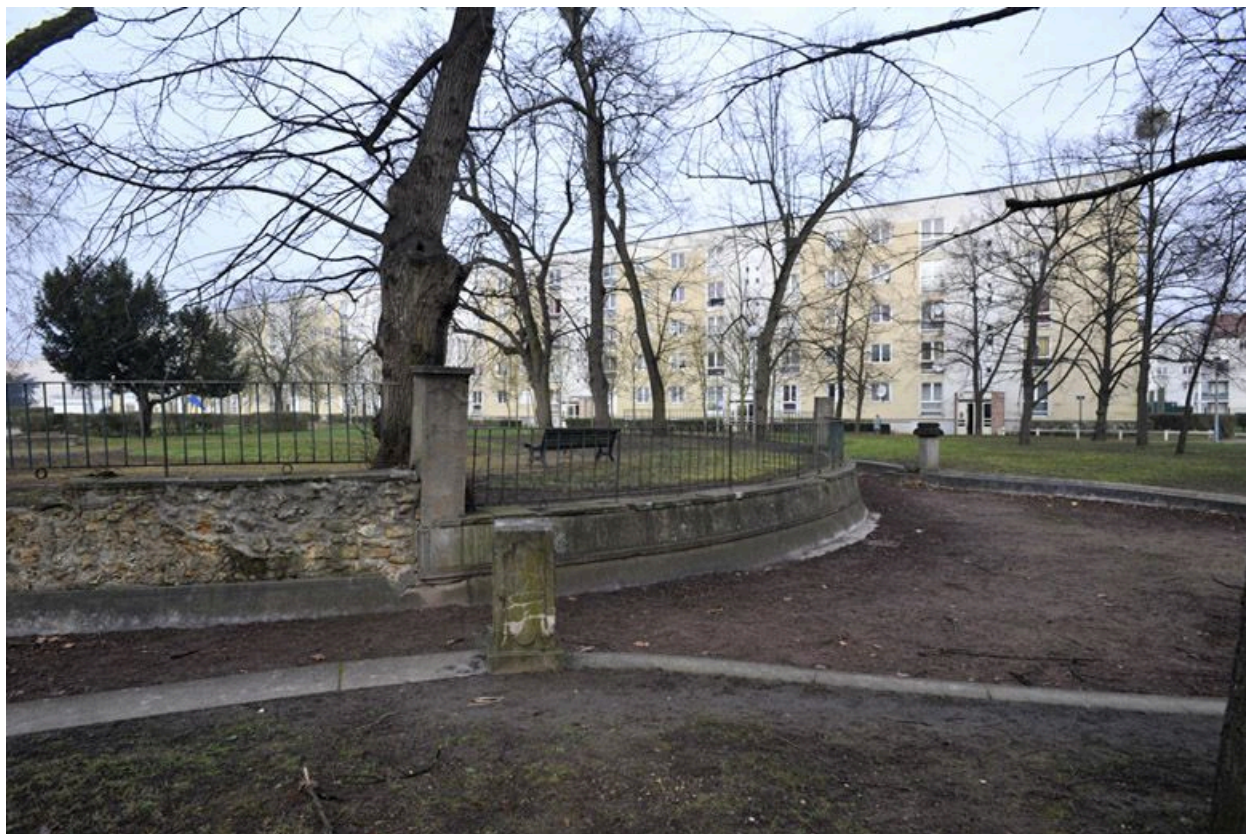
Vernouillet : le lotissement du Parc, vestige de la rivière avec une barre en arrière plan.
