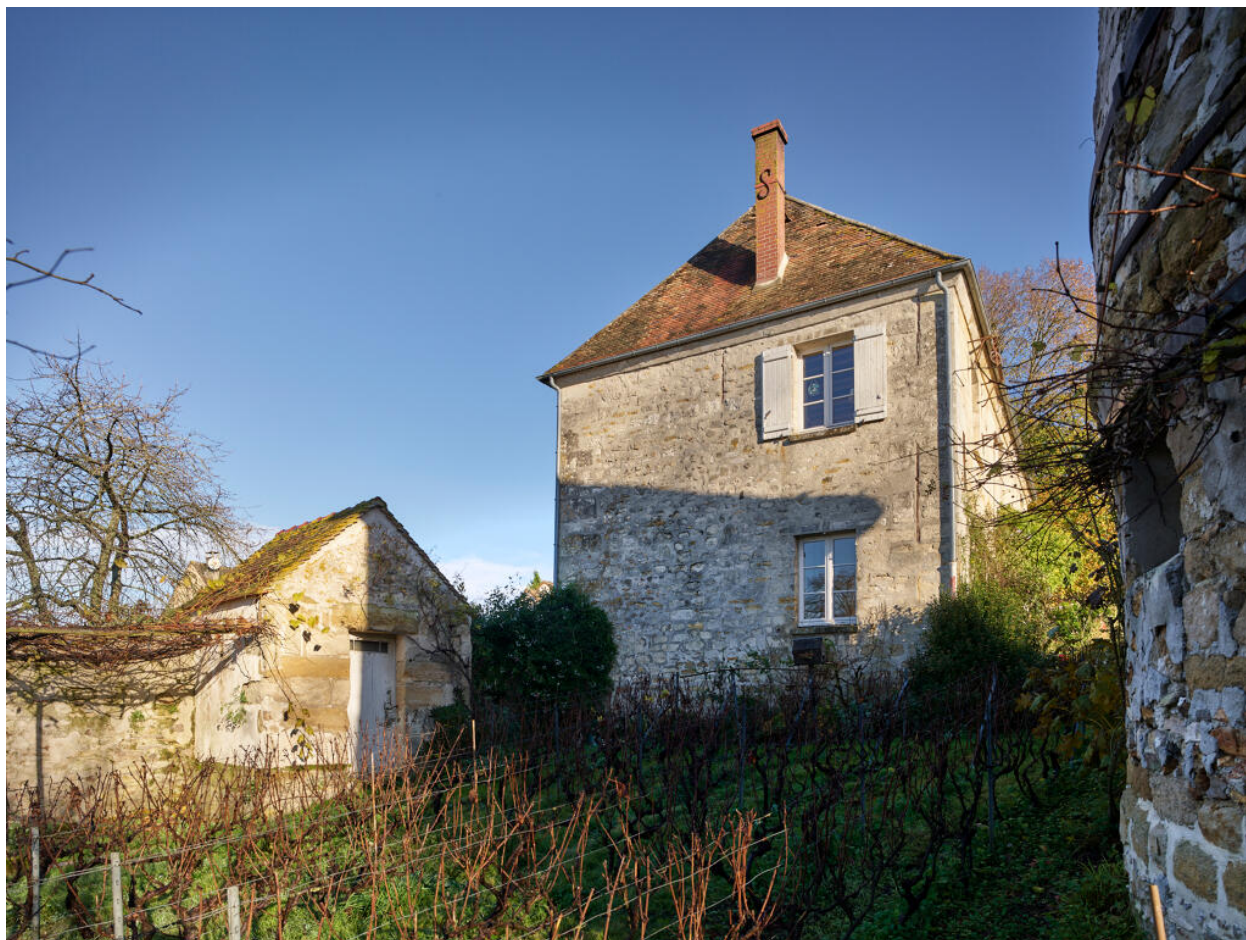
Vue du pignon sud de la maison.
