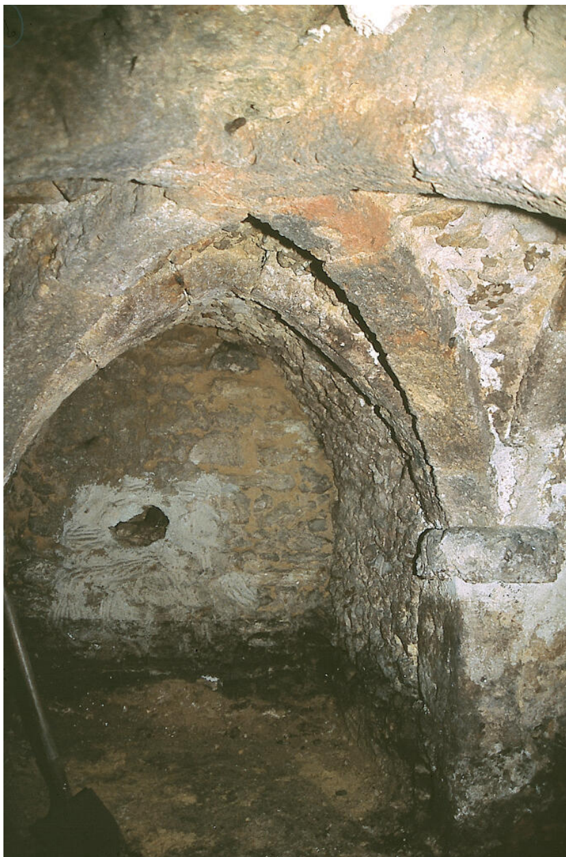
Détail des voûtes de la cave médiévale.
