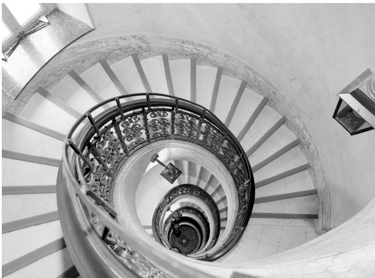
Vue plongeante de l'escalier principal.
