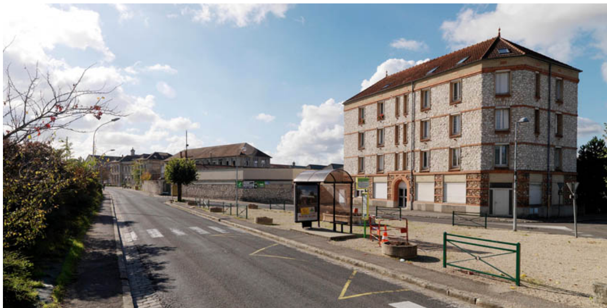
Immeuble 1 place Henri Schneider. Encadrement de porte monumental en briques rouges. Des cordons de briques marquent les niveaux
