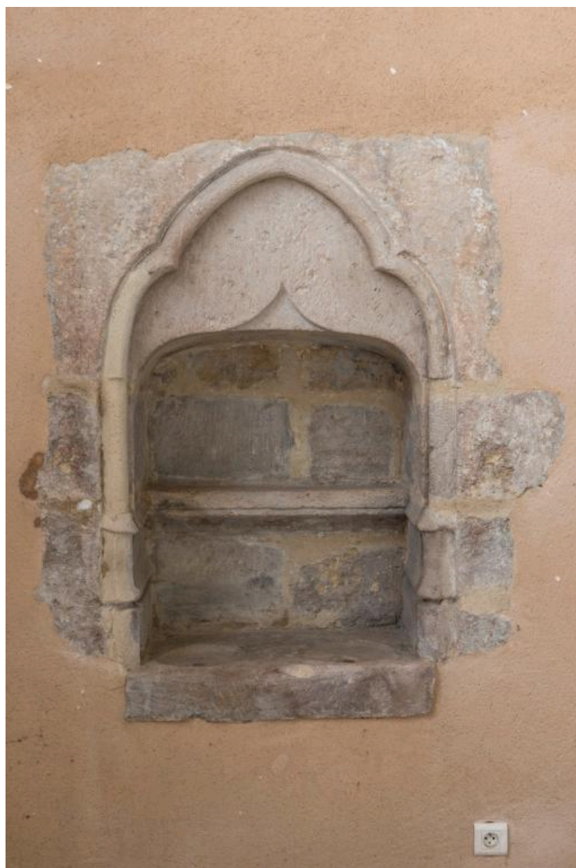
Lavabo liturgique creusé dans le mur sud du chœur.
