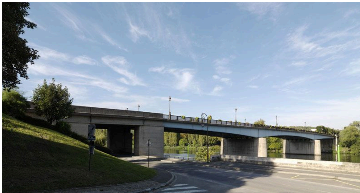
Mantes-la-Jolie : Vue de l'ouvrage vers l'aval depuis les quais de Mantes.
