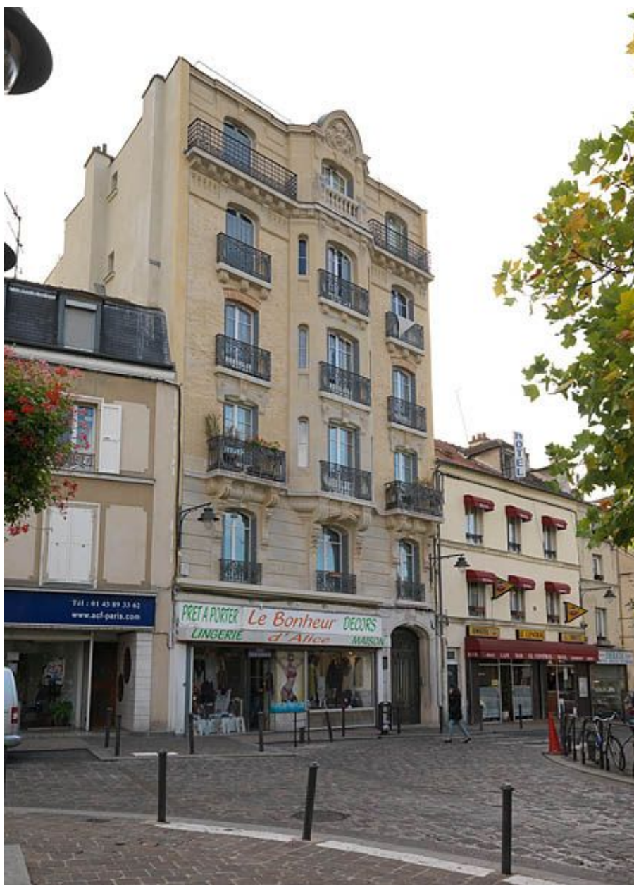
Villeneuve-Saint-Georges, immeuble, 54 rue de Paris. Vue d'ensemble.
