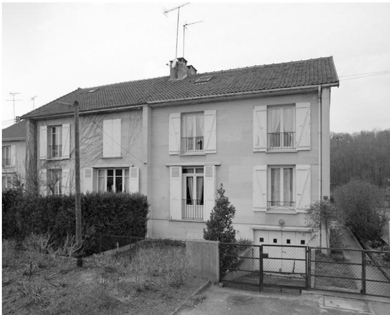
Vue d'ensemble d'un pavillon double à un étage (type B ou C) situé 33-35, avenue du 18 Avril.
