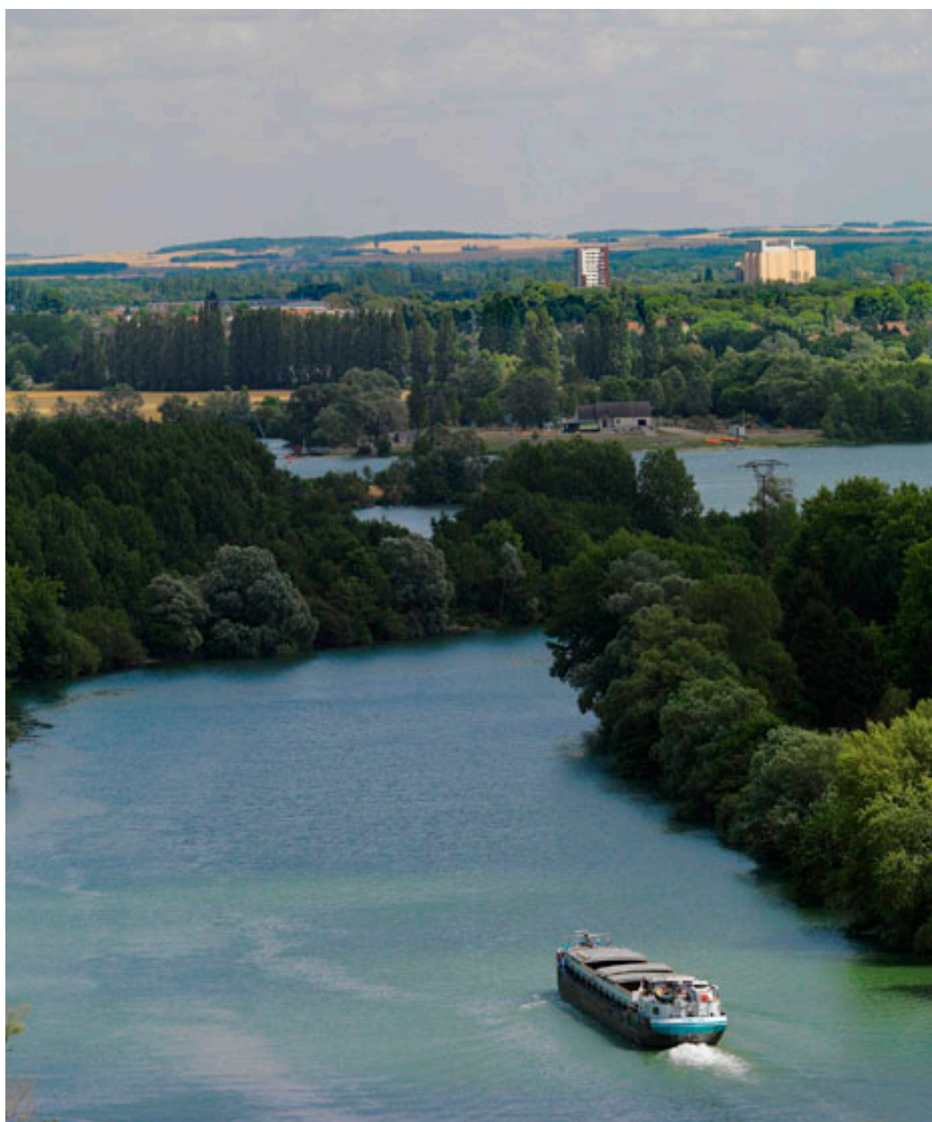
Silos de l'UNCAC Invivo de la Grande Paroisse. Paysages autour du site. Vue sur la Seine depuis la tour de travail du silo 6.
