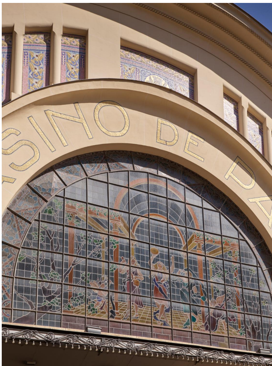
Façade, baie en demi-lune garnie de vitraux
