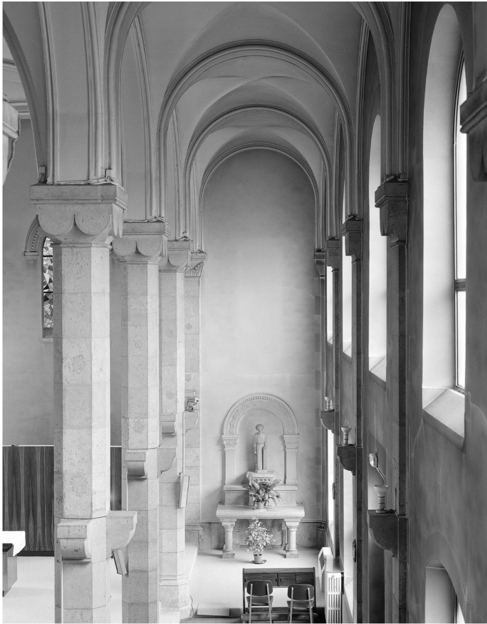
Vue du bas-côté droit de la chapelle.
