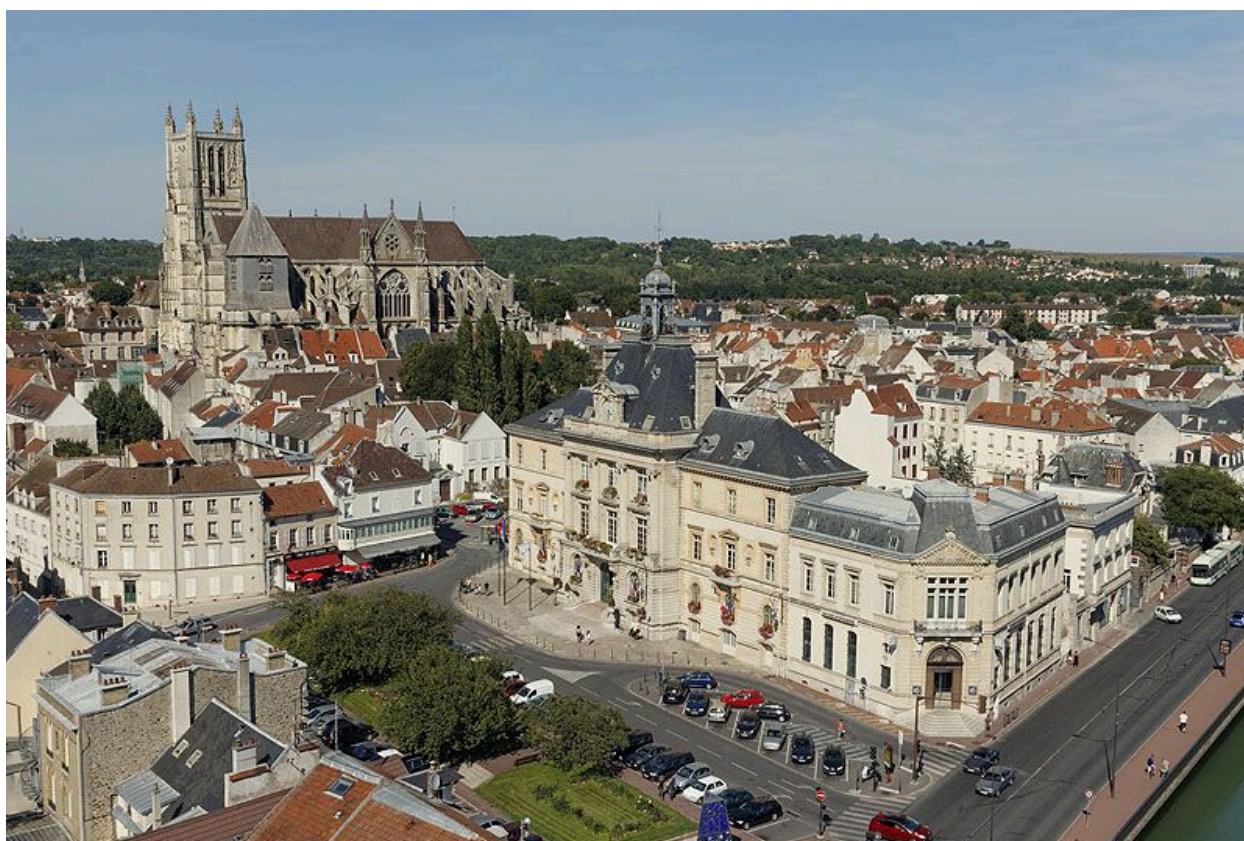
Vue panoramique, prise depuis un ballon captif : la façade de l'hôtel de ville et ses abords.
