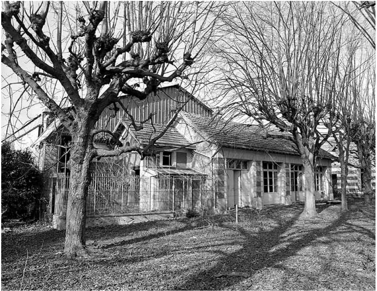
Bâtiments annexes : chenil (?), local syndical (?). Photographie avant destruction de l'usine, 1989. (Ministère de la culture, Inventaire général. 89SG715X)
