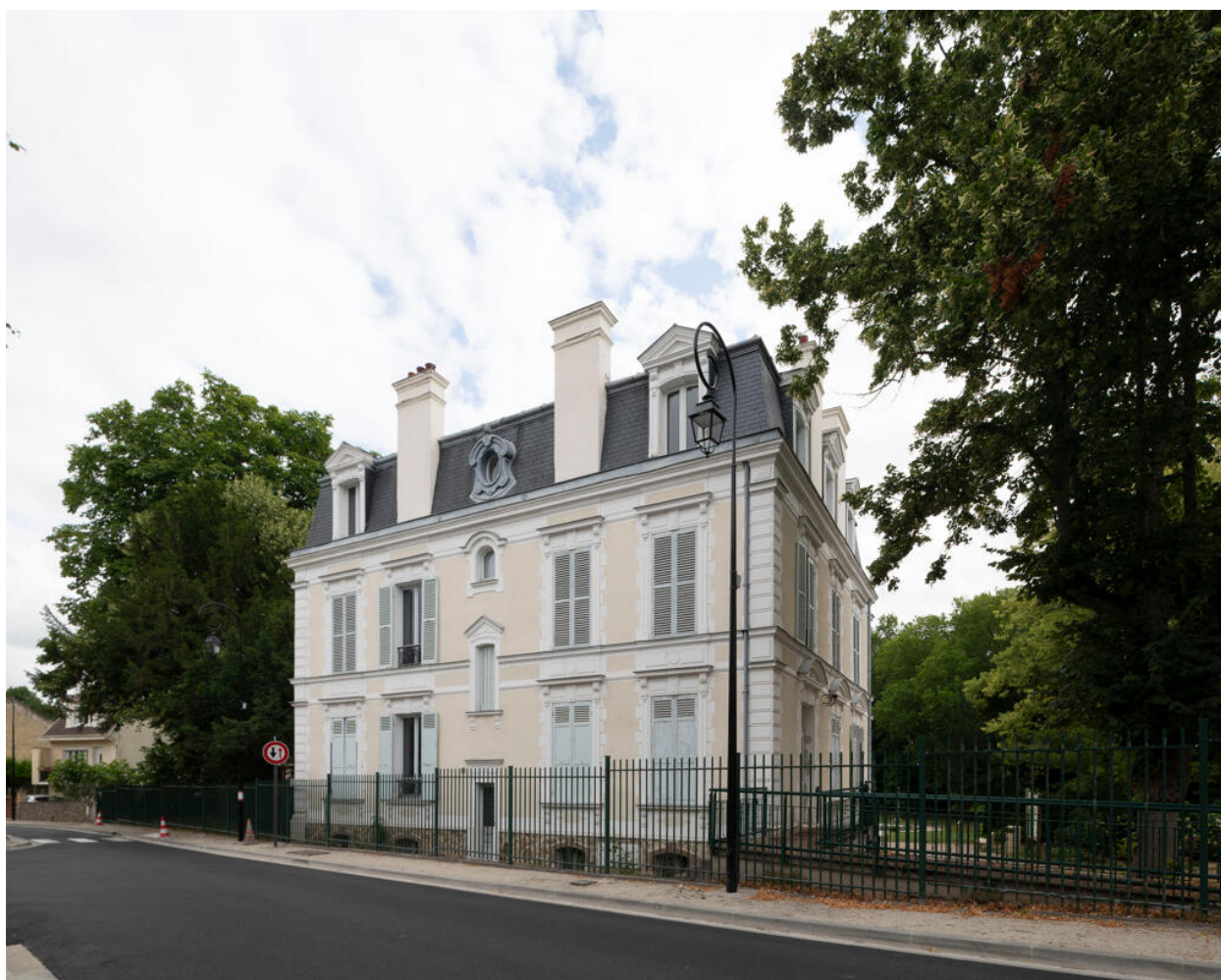
Façade côté rue, orientée sud-ouest. Au centre, l'entrée de service.
