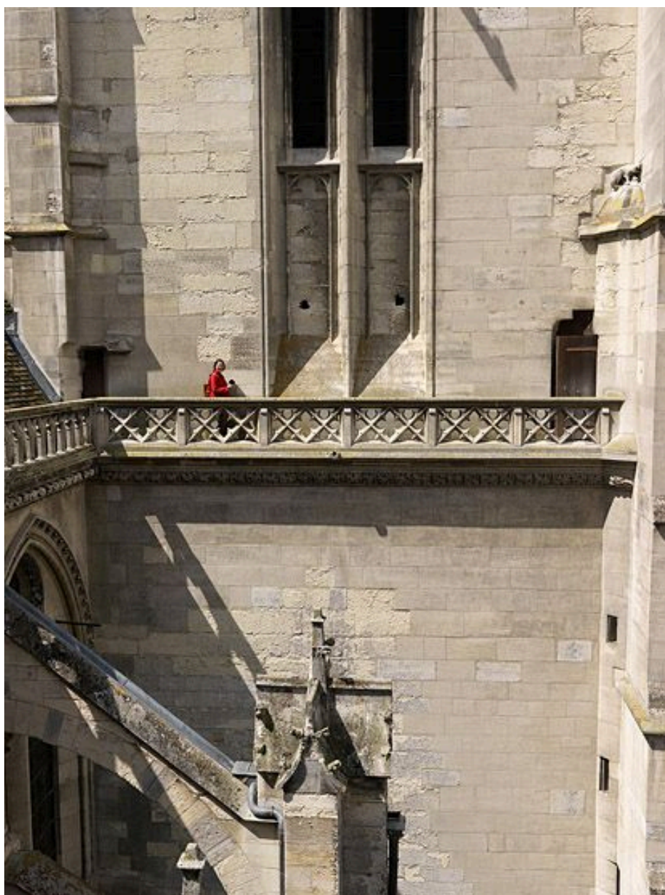
Tour nord, base du 2e niveau : élévation orientale, vue depuis la balustrade au sommet du bras nord du transept.
