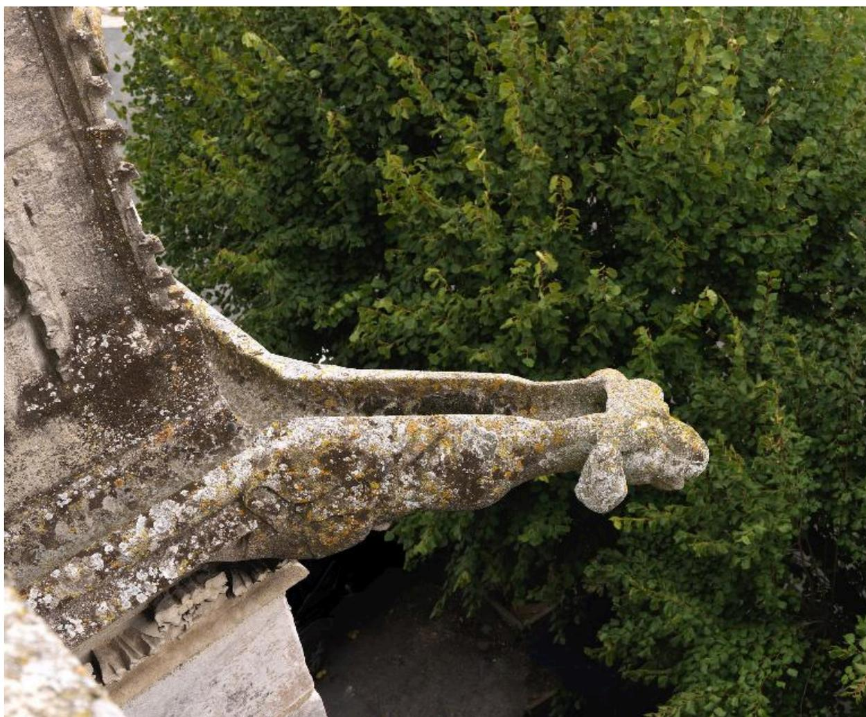
Vue d'une gargouille avec la gorge d'écoulement des eaux.
