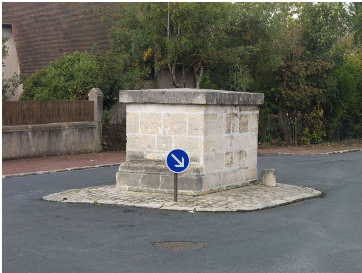
Fresnes, Regard (rue du) 17. Vue sur la façade sud du regard IV.
