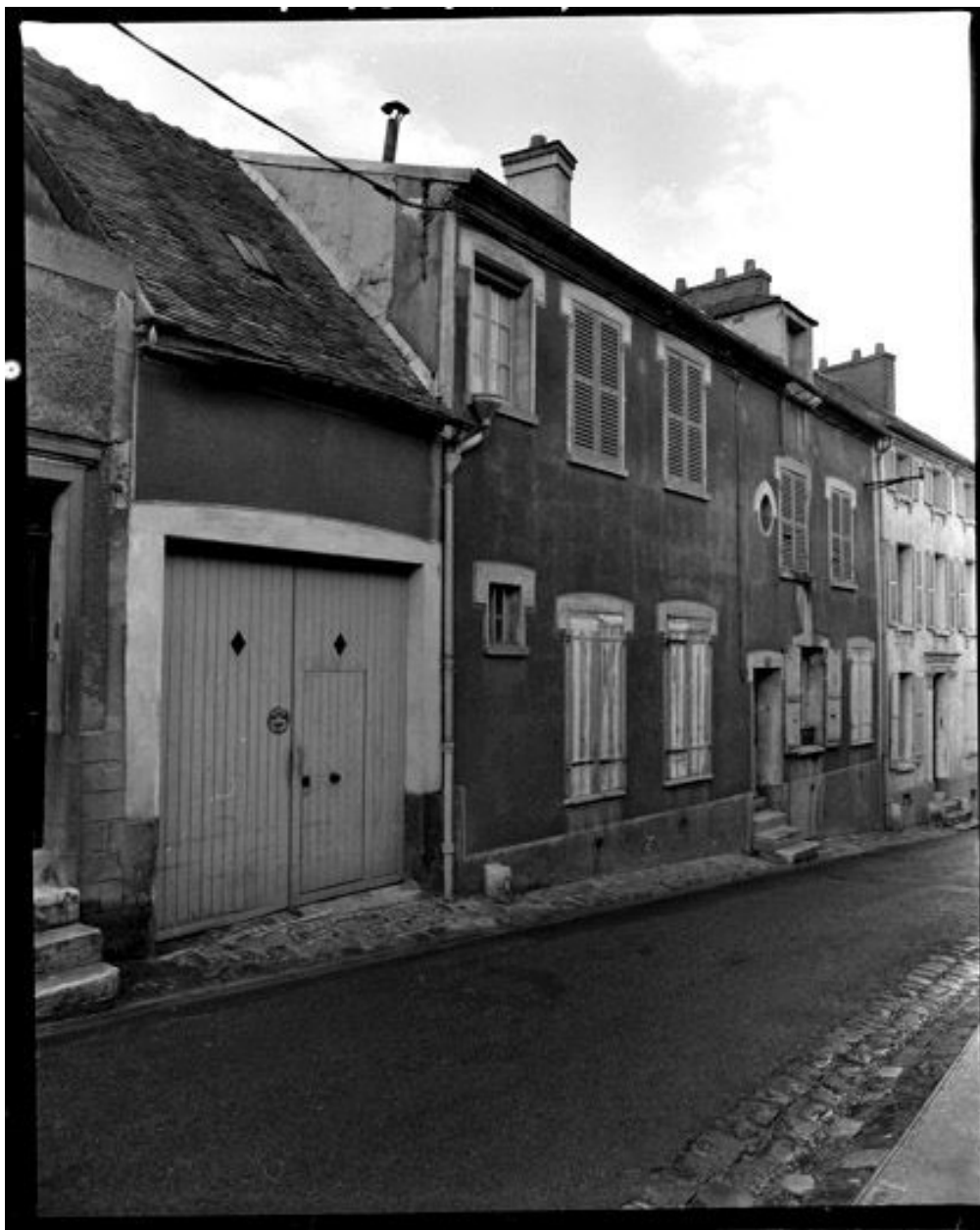
Maison, Gâte-Vigne (rue) 8. Vue d'ensemble depuis la rue.
