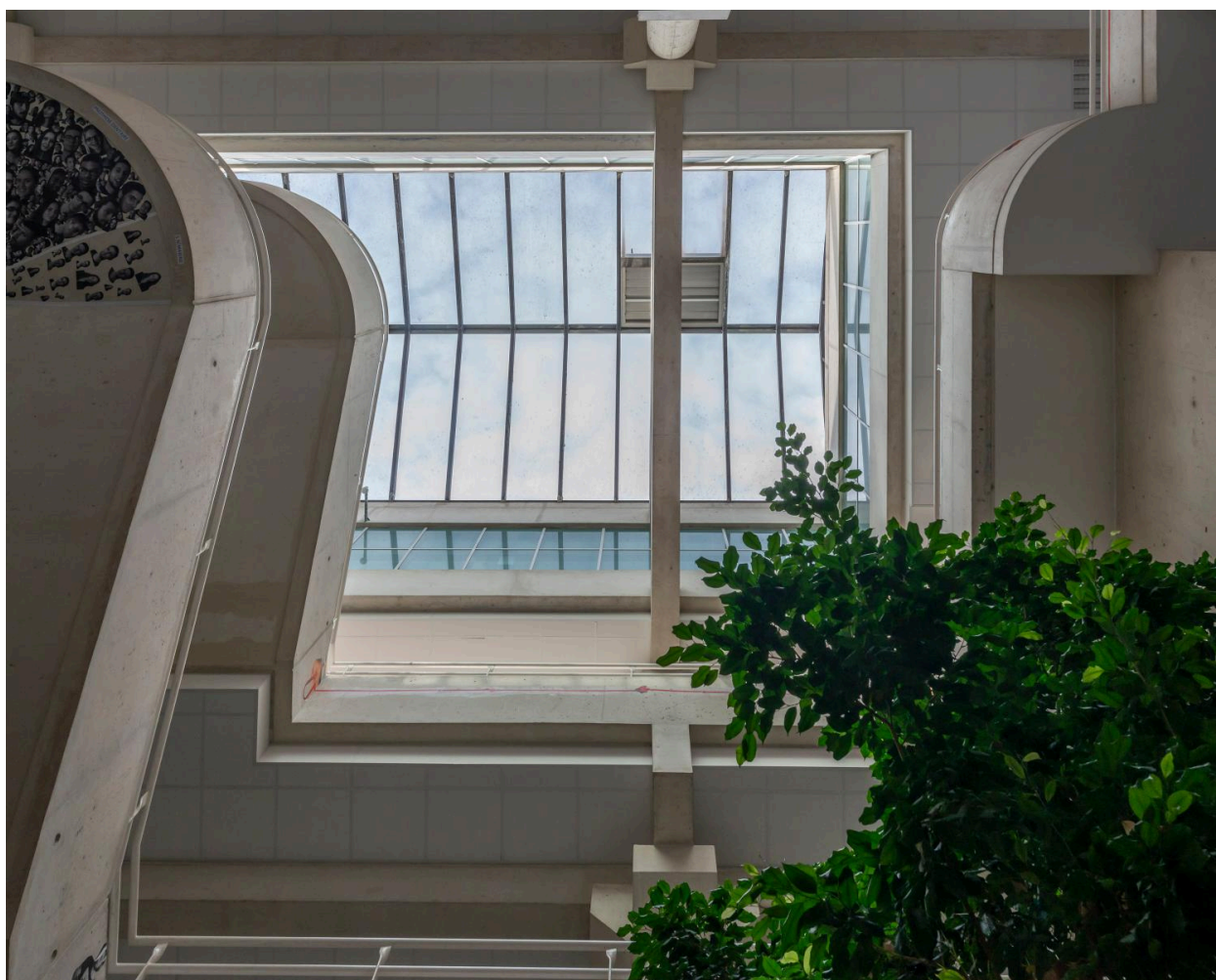
Détail de la verrière zénithale qui couvre le hall du lycée, ainsi baigné de lumière.
