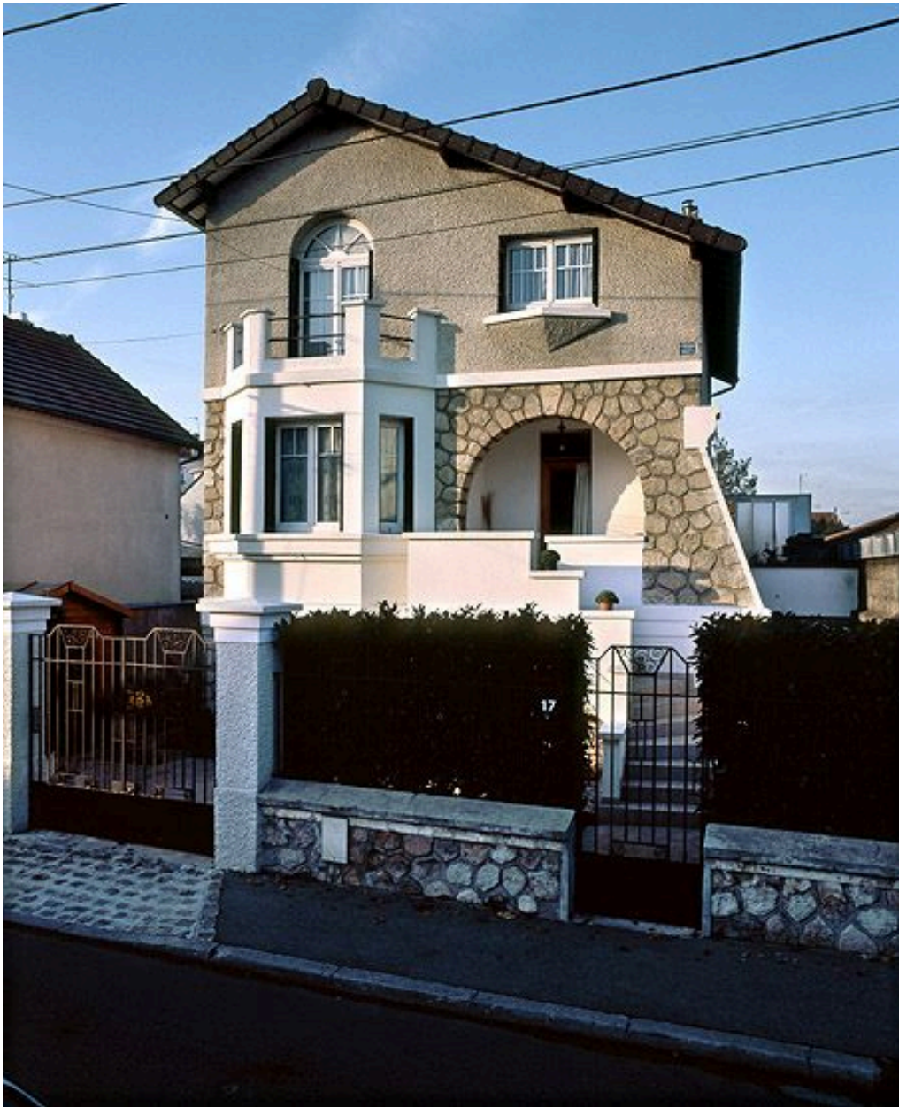
Maison, 17 rue d'Avron.
