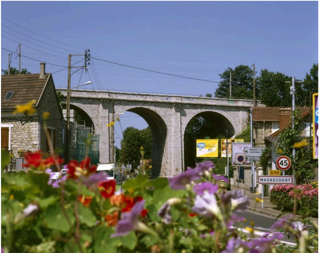
Vue d'ensemble du pont.
