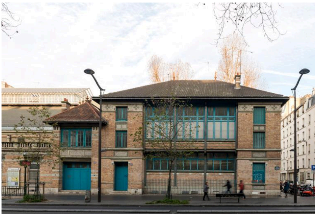
L'élévation antérieure des bains-douches accolés en 1913-1914 au gymnase dit "d'Allemagne", rue Jean Jaurès (Paris, 19e).
