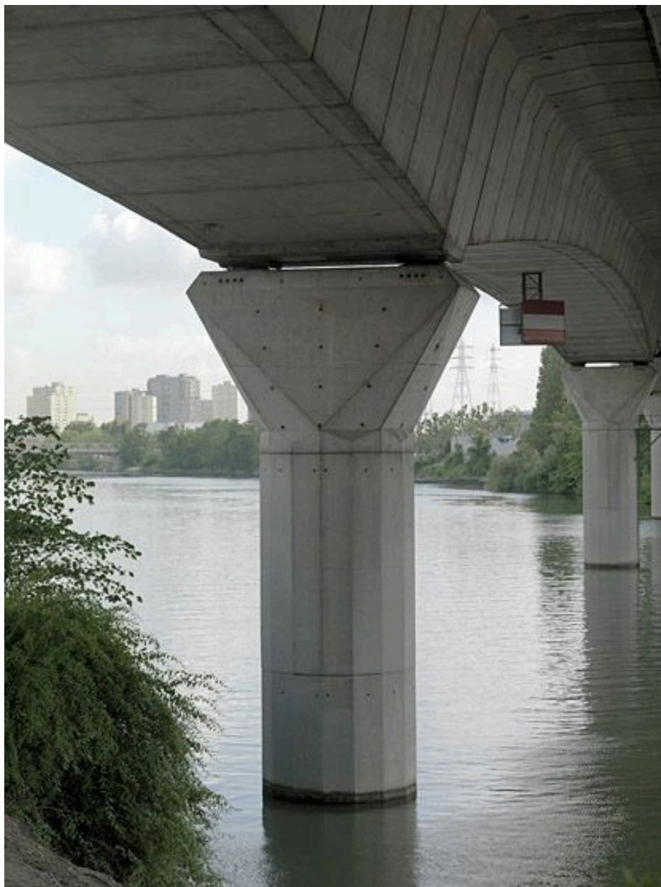
Choisy-le-Roi, Alfortville, Vitry-sur-Seine. Pont de Choisy de l'A86. Détail d'une pile en rivière.
