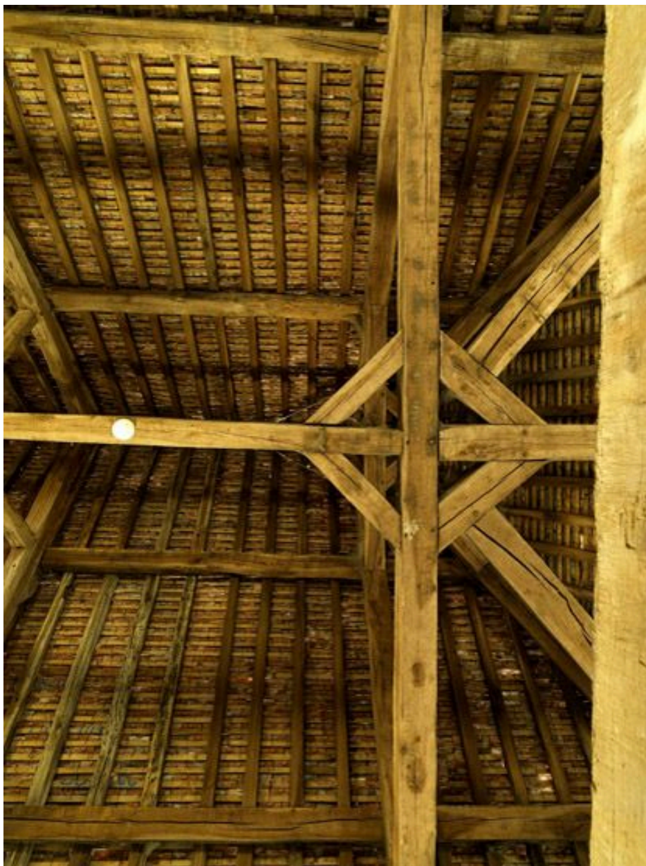
La charpente : vue d'une ferme.
