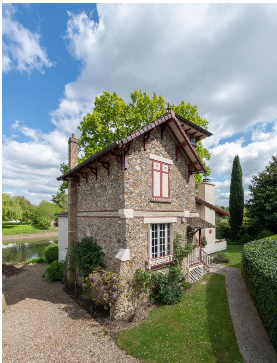
Angle des façades nord et ouest. A l'arrière plan, la Seine.
