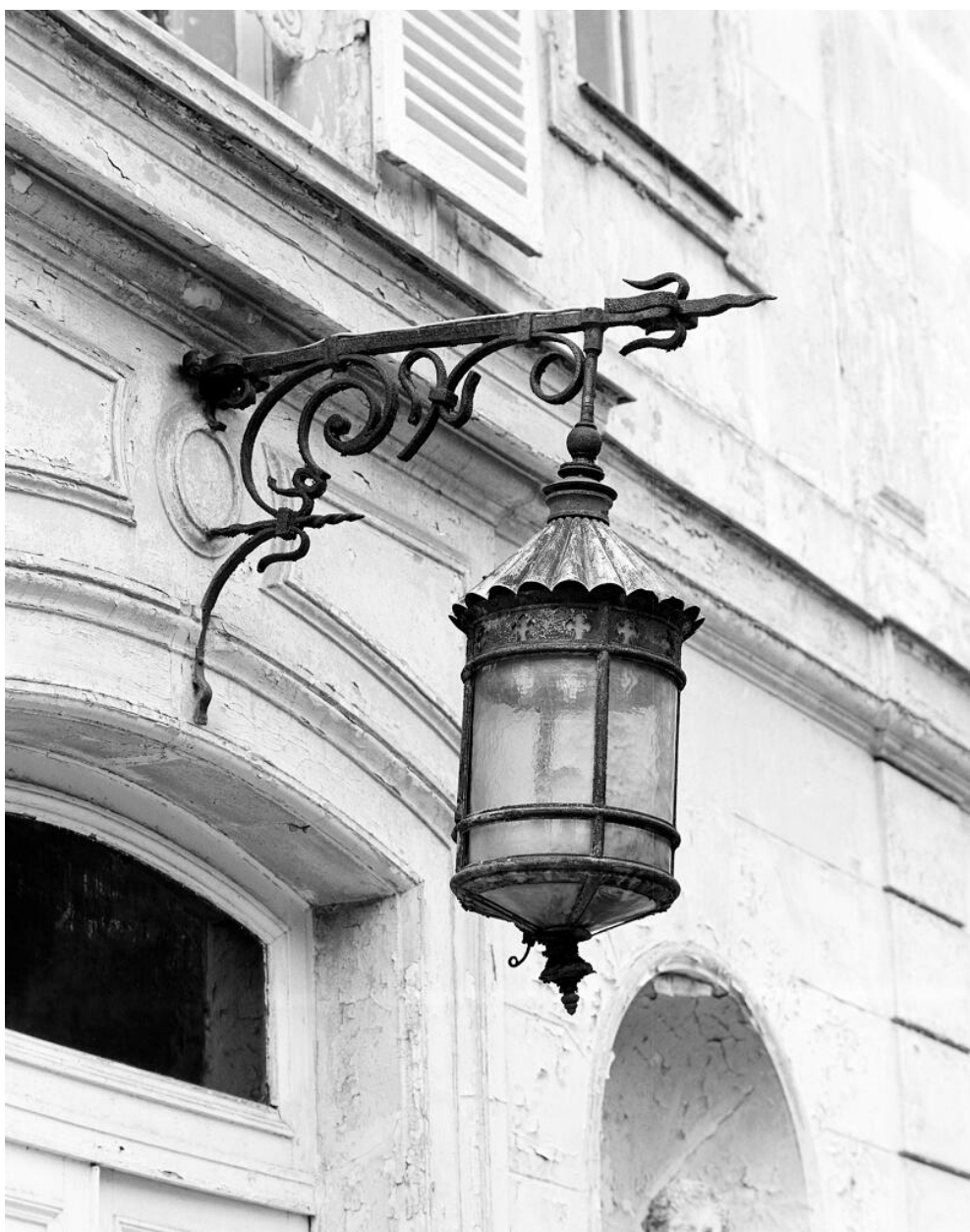
Façade antérieure : détail de la lanterne au-dessus de la porte d'entrée.
