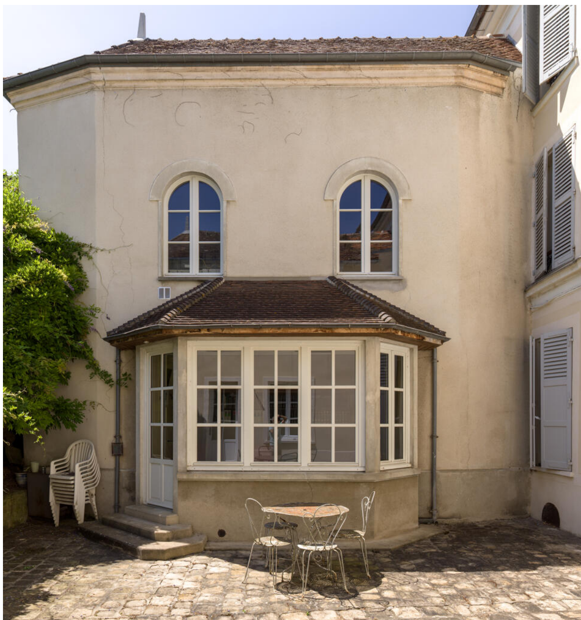
Vue générale de l'aile ouest donnant sur cour depuis l'est.
