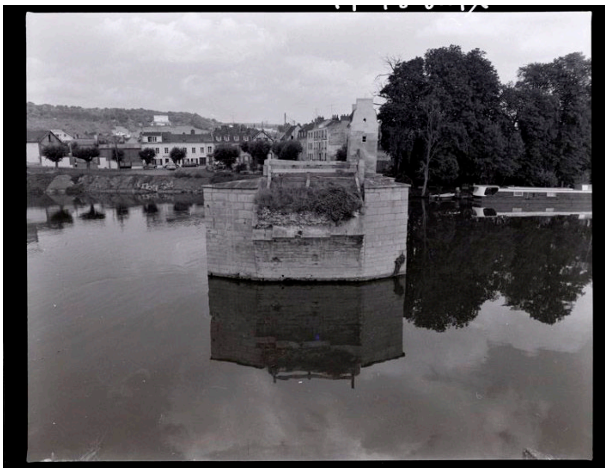
Pont routier dit Vieux pont de Limay. Vue depuis la rive gauche.
