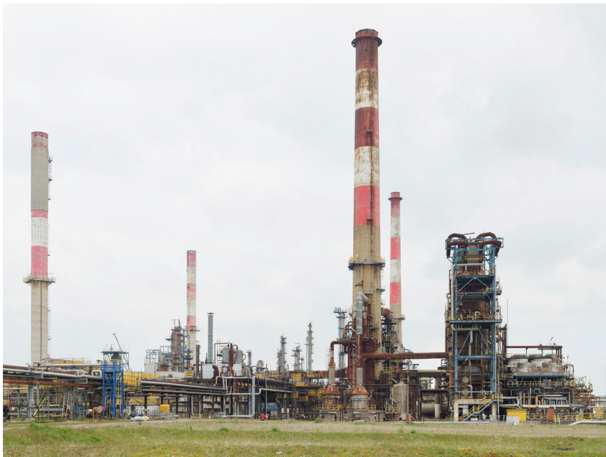
Vue générale des unités de production. Au premier plan, les Unités Ouest.
