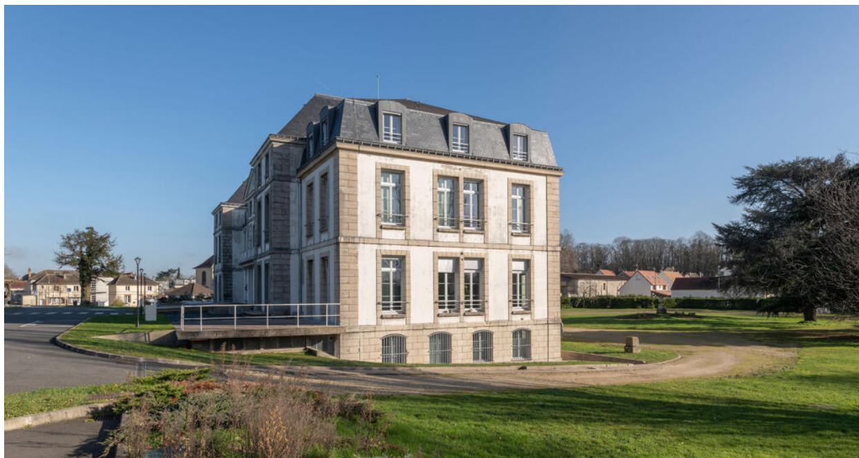
La façade sud, adjonction à l'extrémité du bâtiment.
