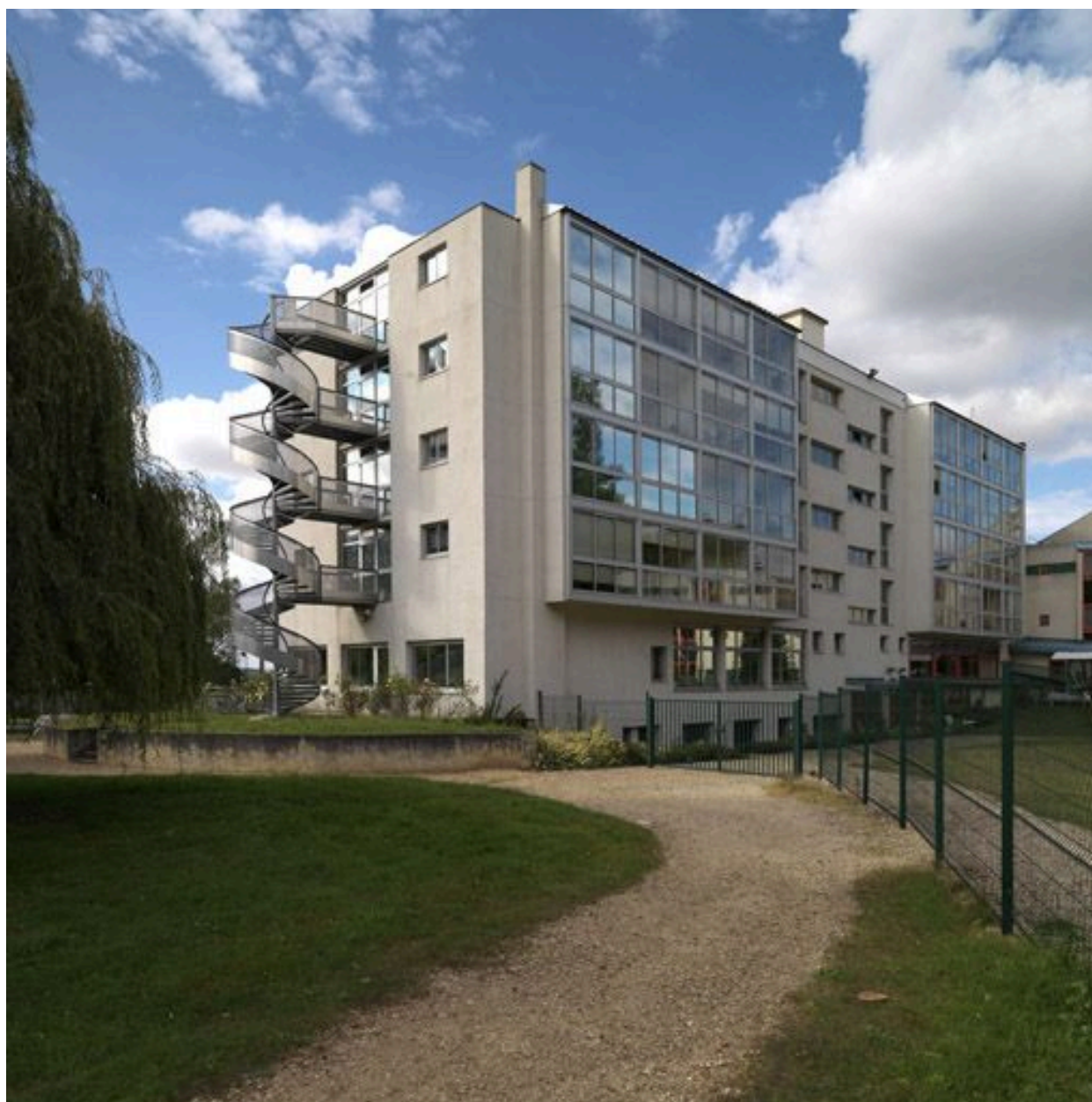
Façade arrière du premier corps de bâtiment (1967).
