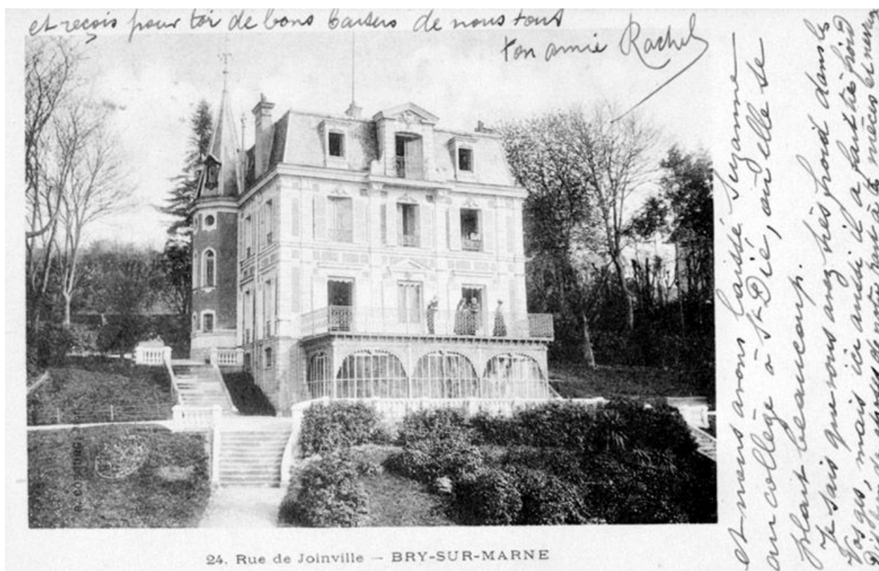
Maison, 24 rue de Joinville aujourd'hui avenue du Général Leclerc. Carte postale. (Collection particulière)
