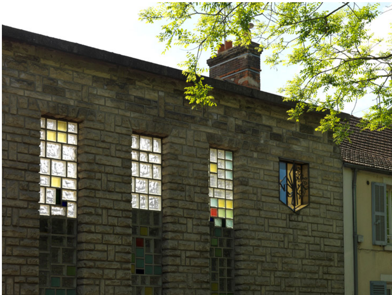
Façade d'un ancien équipement, 45 rue de Lorraine.
