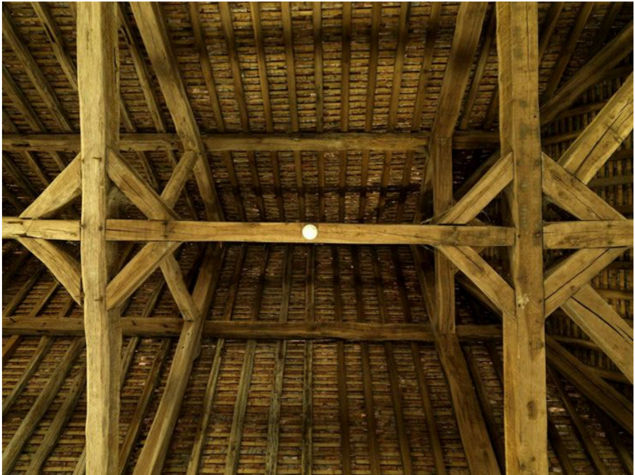
La charpente : vue de deux fermes.
