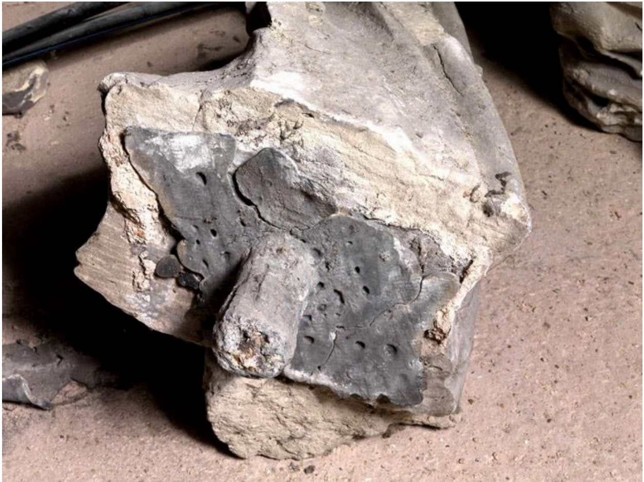
Pinacle : vue de la base, avec détail du scellement au plomb.
