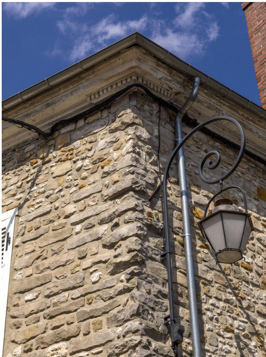
Détail des vestiges du décor de la façade du 71 rue Langlois (ou 1 rue Charles Cochin).
