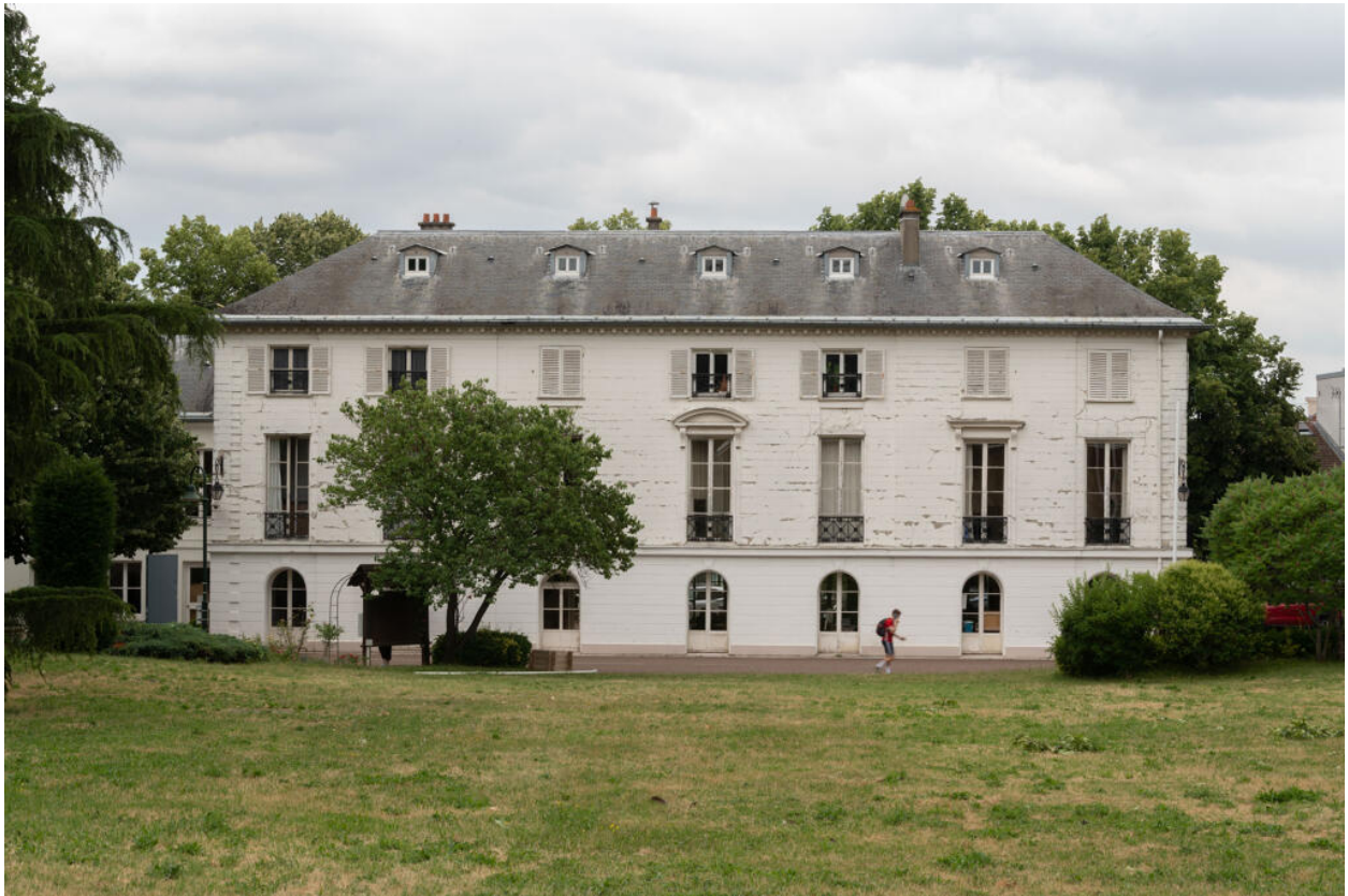
La façade postérieure.
