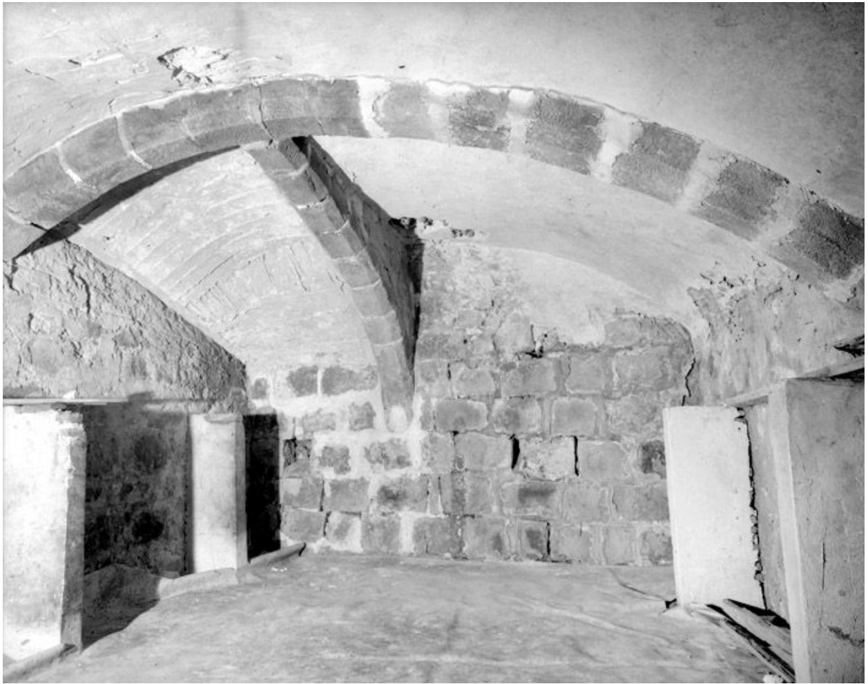
Partie sud de la cave, voûtée en berceau avec arcs doubleaux. Vue d'ensemble, depuis l'ouest.
