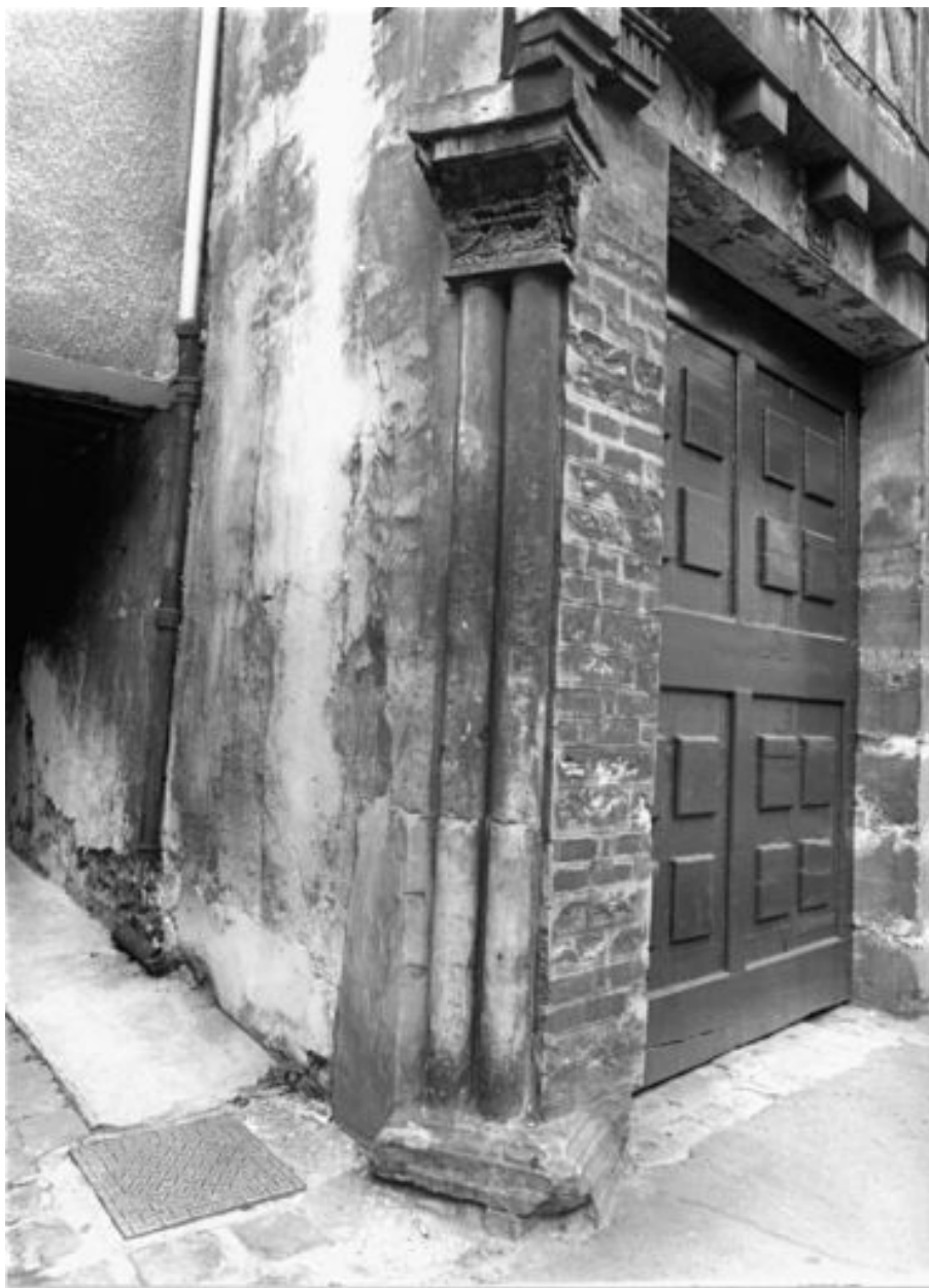
Maison, 28 Grande rue Garles de Gaulle. Détail de remplois de provenance inconnue.
