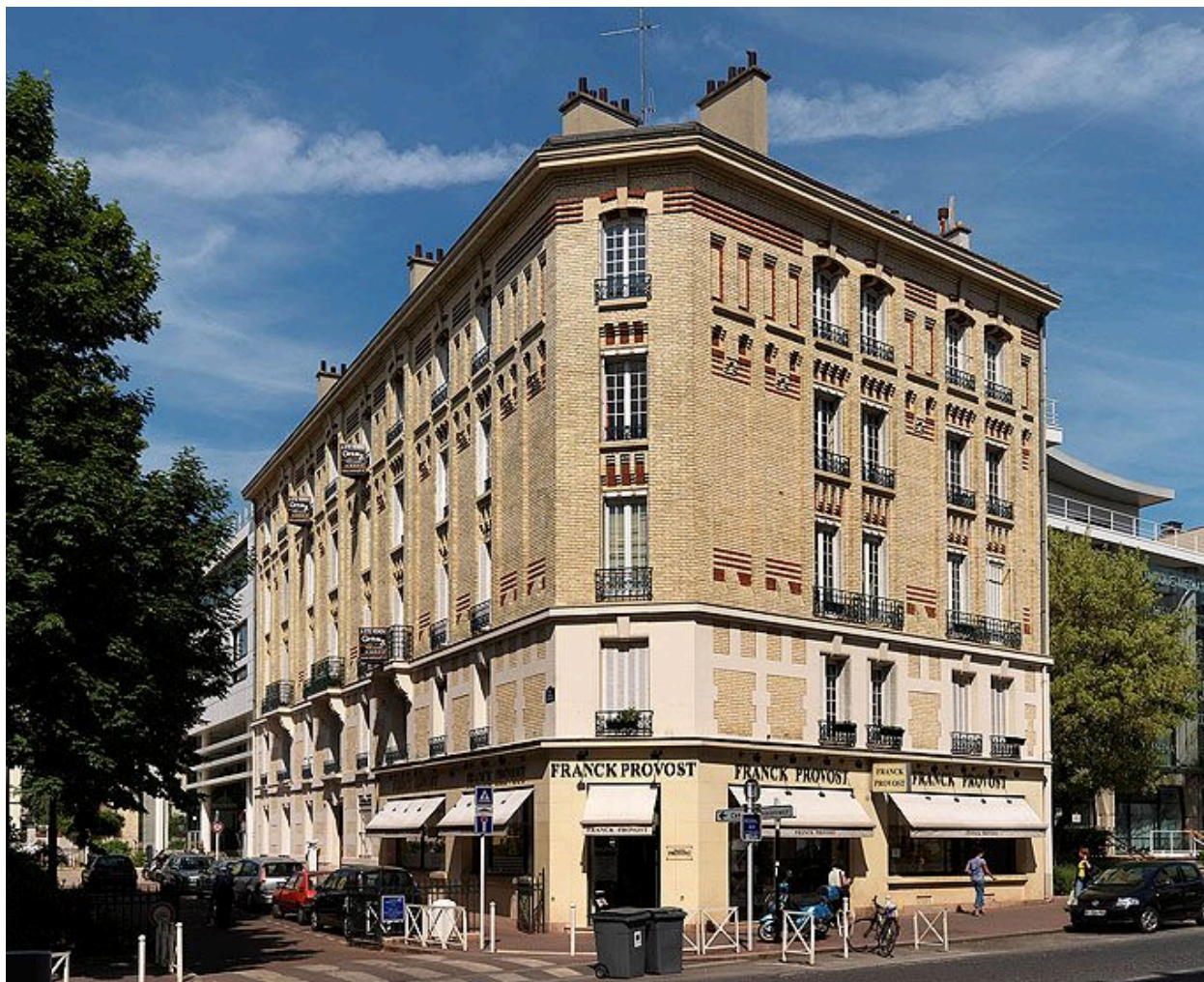
92, Montrouge, immeuble , 2 place de la Mairie. Façade sur la place de la Mazirie.
