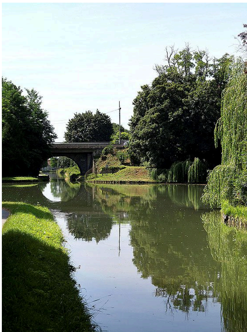
Le canal et le port à la limite des communes de Meaux et de Villenoy, vu depuis Meaux. Dans le fond, le pont de la chaussée de Paris.
