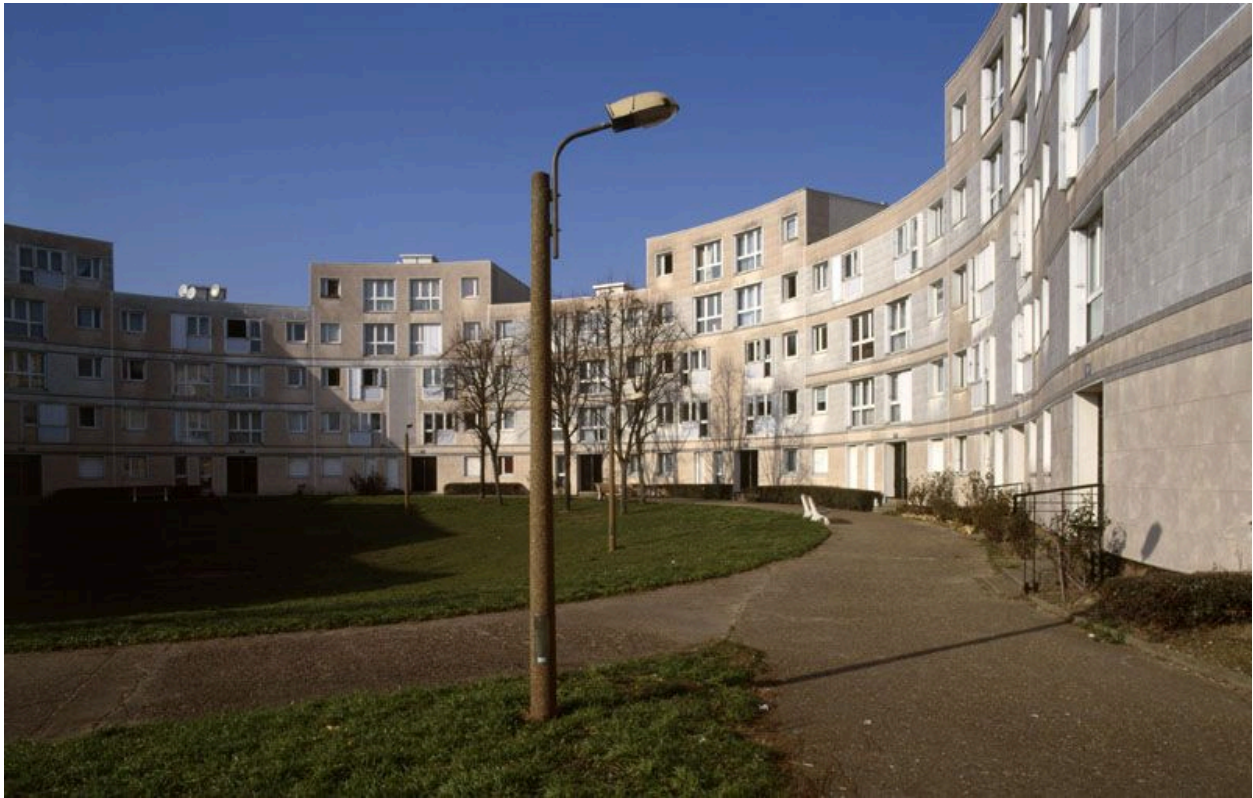
La Noé. Autre vue actuelle du bâtiment serpentin de l'Ellipse.
