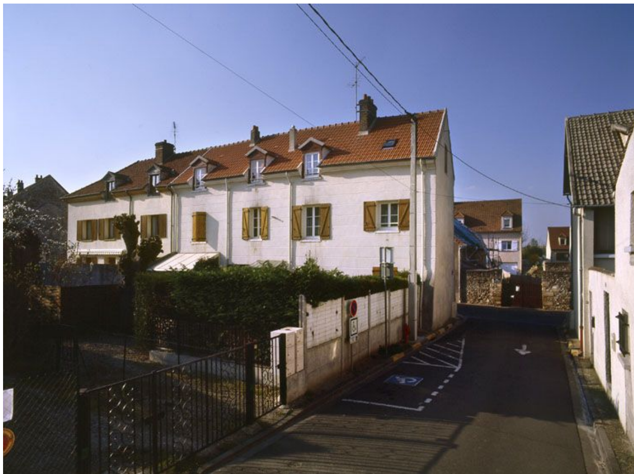
Vue d'une ancienne maison de campagne du XVIIIe siècle découpée en plusieurs parcelles. La façade sur jardin.
