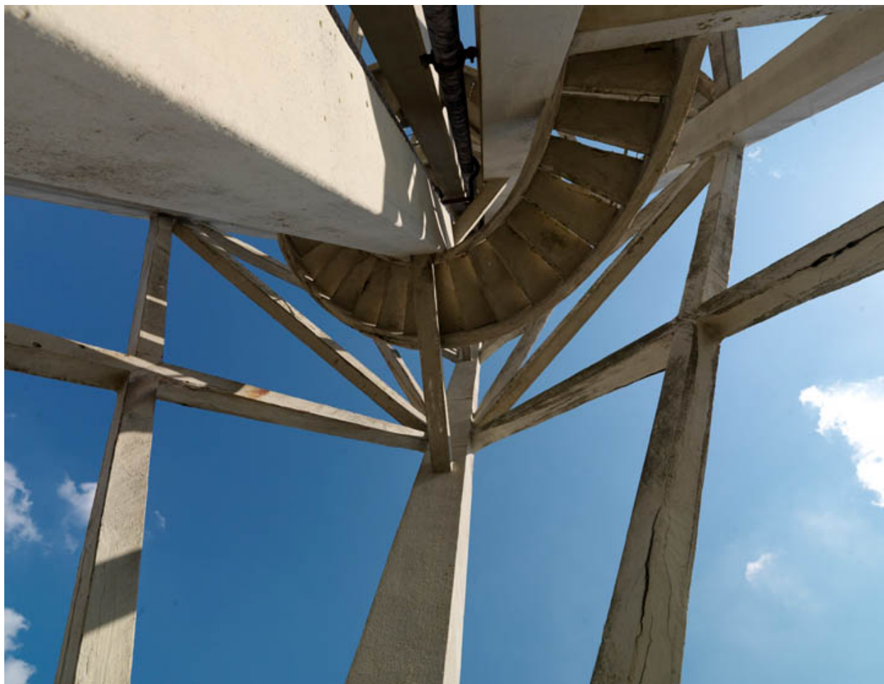
Détail de la structure du château d'eau (1902). Ciment armé.
